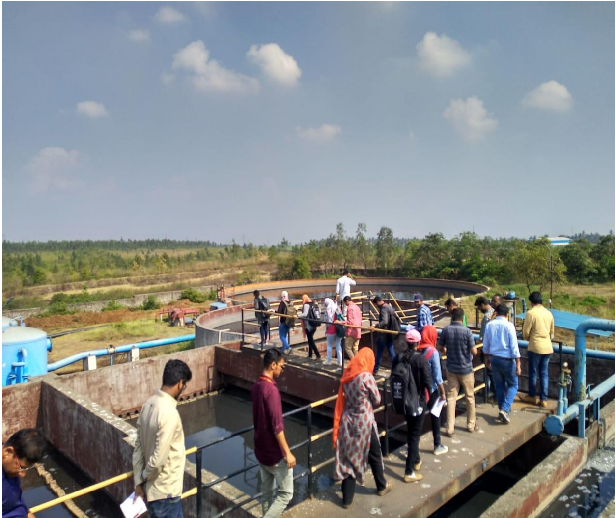
CETP KAGAL, KOLHAPUR
